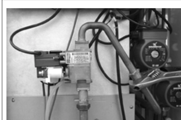
Foto P: Sconnessione tubo alimentazione gas Foto P : Desconexión tubo alimentación gas
