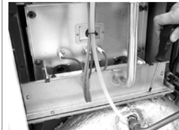
Foto O: Vite a croce di fissaggio cassetti anteriori camera stagna Foto O : Tornillo con ranura en cruz de fijación cajones anteriores de la cámara estanca
