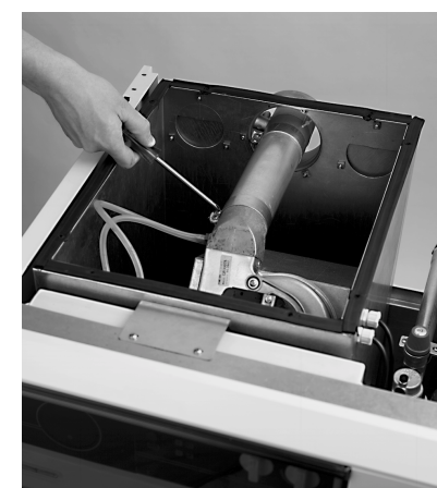
Foto M: Rimozione tubo collegamento ventilatore Foto M : Extracción del tubo de conexión ventilador
