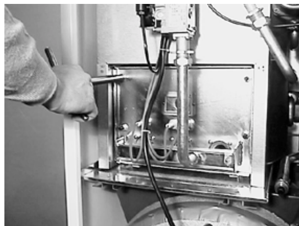
Foto M: Rimozione piastra bruciatori Foto M: Extracción de la placa quemadores
