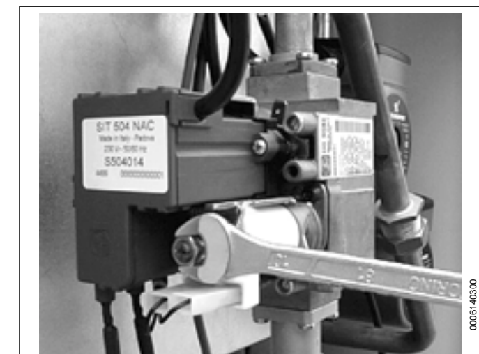
Foto G: Ghiera modulatore regolazione max Foto G: Virola del modulador regulación máx
