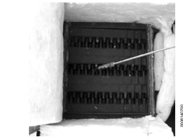
Foto P: Pulizia canali di fumo corpo in ghisa Foto P: Limpieza canales de humo cuerpo fundición
