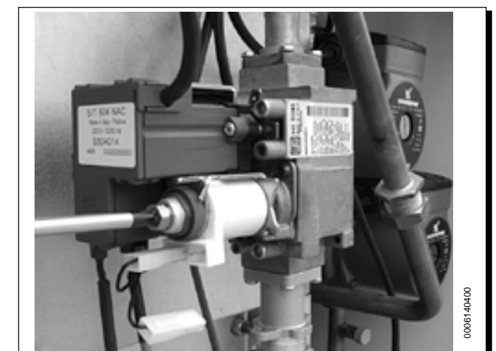
Foto H: Vite modulatore regolazione min Foto H: Tornillo del modulador regulación Min
