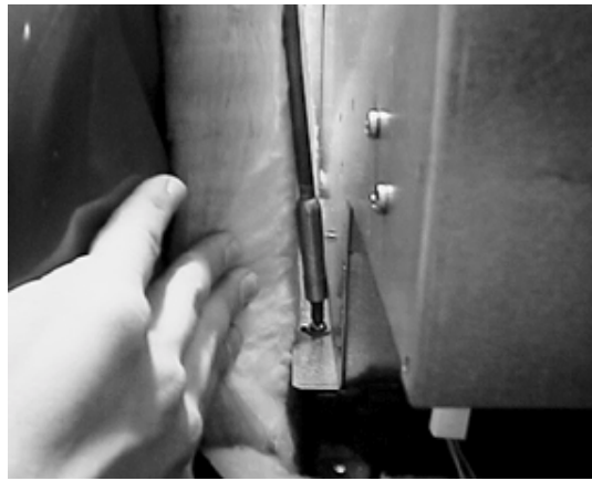
Foto I: Rimozione cappa fumi Foto I: Extracción de la campana humos
